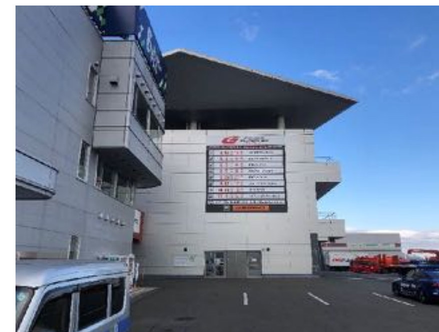
地下通路入口
