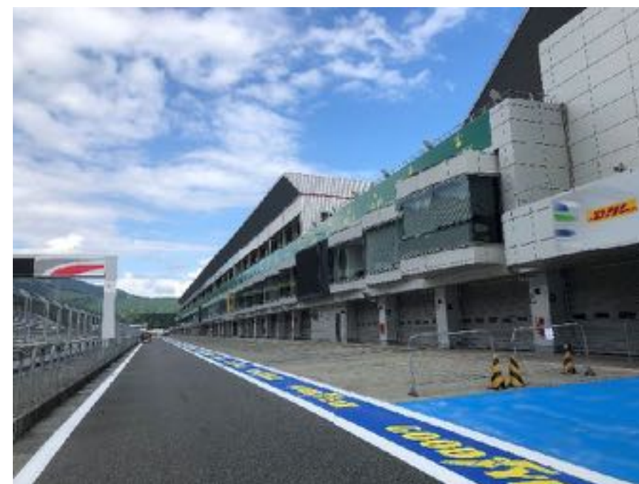
コントロールセンター屋上
